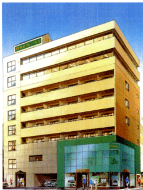
平成9年に建てかえられた元町4丁目ビル
