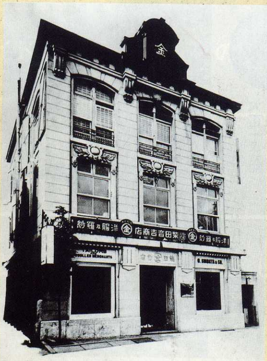
元町3丁目にあった創業当時の建物(写真上)と店内(写真下)
